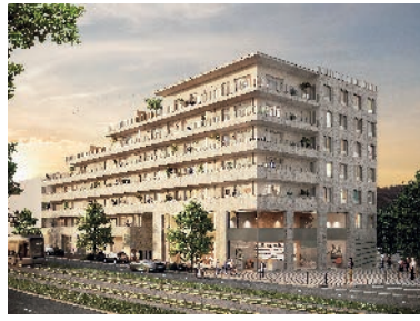
CHÂTENAY-MALABRY - Estrella Co-promoteur : EIFFAGE IMMOBILIER Architecte : Ateliers 2/3/4 ARCAS
